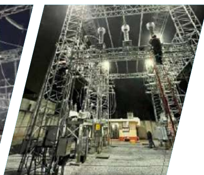
Ampliación subestación Ciudad Quetzal 69 KV
