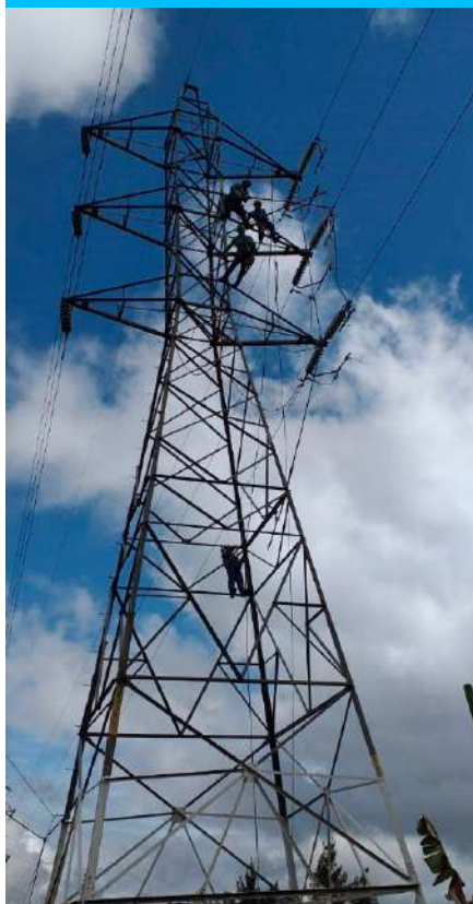
Mantenimiento a torre de línea de transmisión
