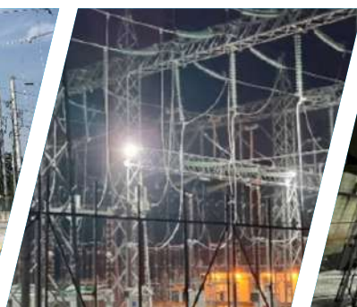
Ampliación subestación Guate Sur 230 KV
