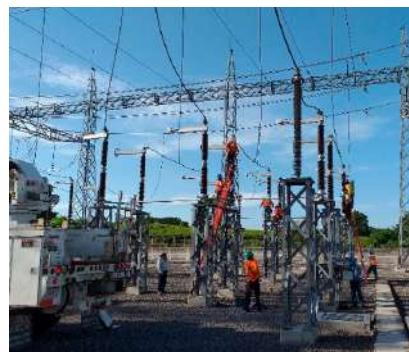
Mantenimiento general a subestaciones
